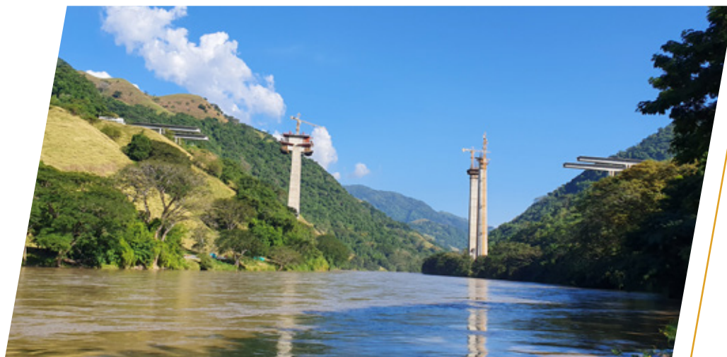
Puente Río Cauca. Se reforzaron los turnos de trabajo para consolidar el buen ritmo de construcción que se lleva a cabo.
