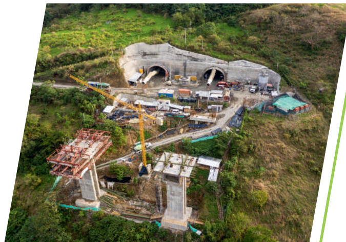
El túnel Mulatos es una infraestructura doble tubo y tiene 2,5 km de longitud.
